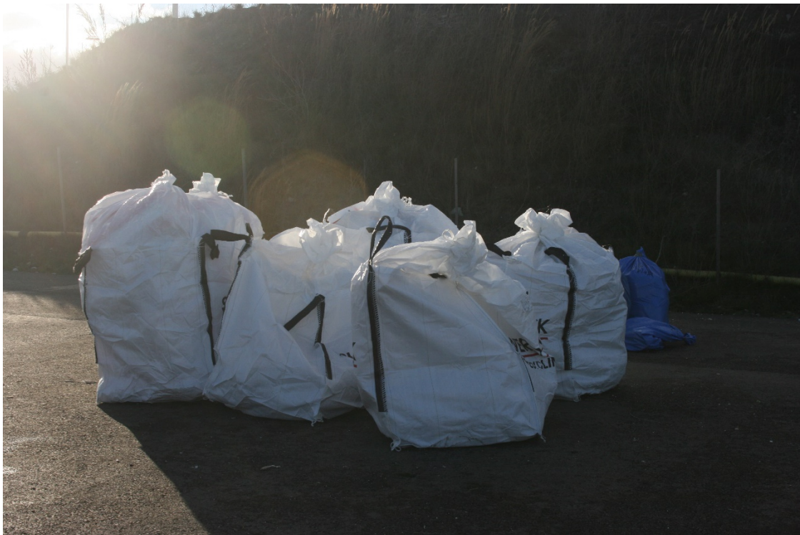
Figur 46. Olika materialfraktioner från det brännbara rivningsavfallet (prov2) packas och märks och efter utförd plockanalys.
